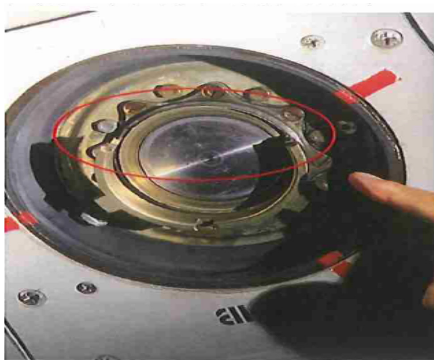
飛機加油口受損情形
