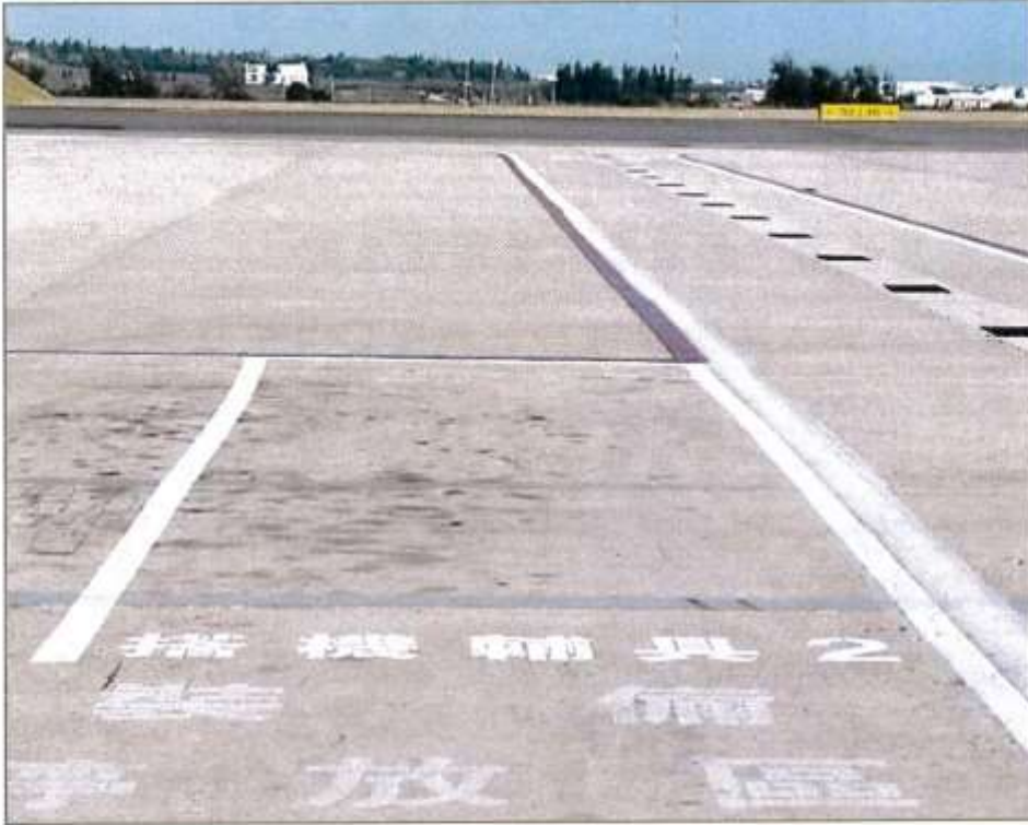
5 號停機位北側
