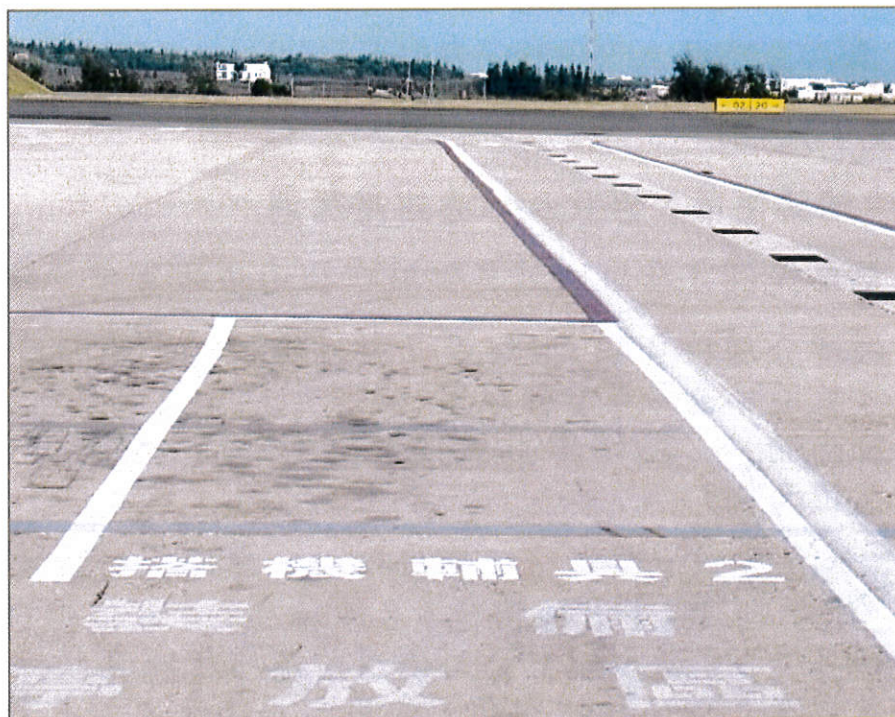
5 號停機位北側
