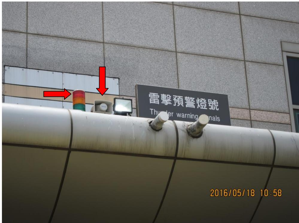
當雷暴(雨)接近，啟動雷擊告警系統-黃燈
